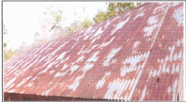
FOTO 2: ENTECHADO DE COCINA
